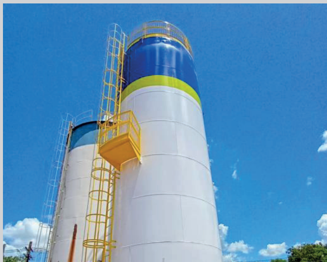
Esta nova etapa de obras sucede intervenções recentes realizadas no mesmo local
